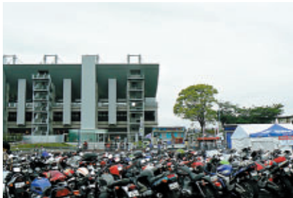
グランドスタンド手前には特設二輪専用駐車場
